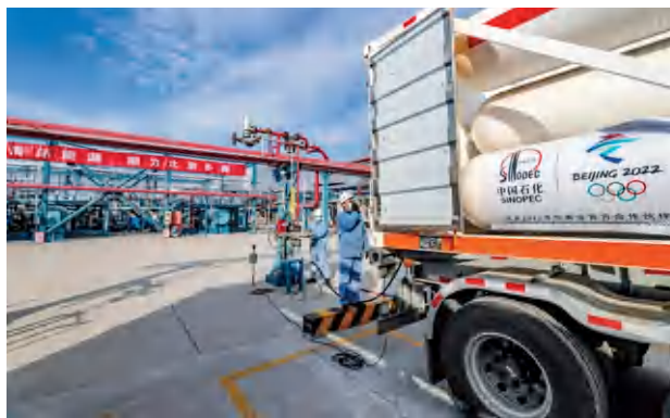
3月21日,燕山石化化学品厂氢气新能源充装现场(李雪 摄)
