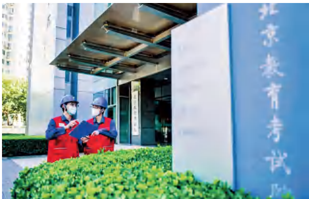
6月，海淀公司为中考保障用户开展电力设备状态检测工作
