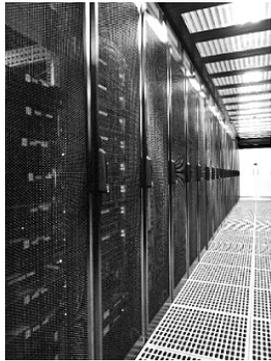
个机柜位, 符合美国 T3+ 级标准, PUE < 1.5。采用双路供电, 电力来自2个独立变电站。电信、移动、联通三大运营商设立核心网络节点, 超过百人的运维和安保团队为其提供7×24小时全方位安全保障。7月, 该数据中心通过中国质量认证中心(CQC) A级机房认证。截至年底, 有互联网、金融、电商等行业多家客户入驻, 入驻率80%。
